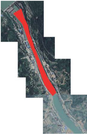
图 1 龚嘴水电站坝下探测区域
